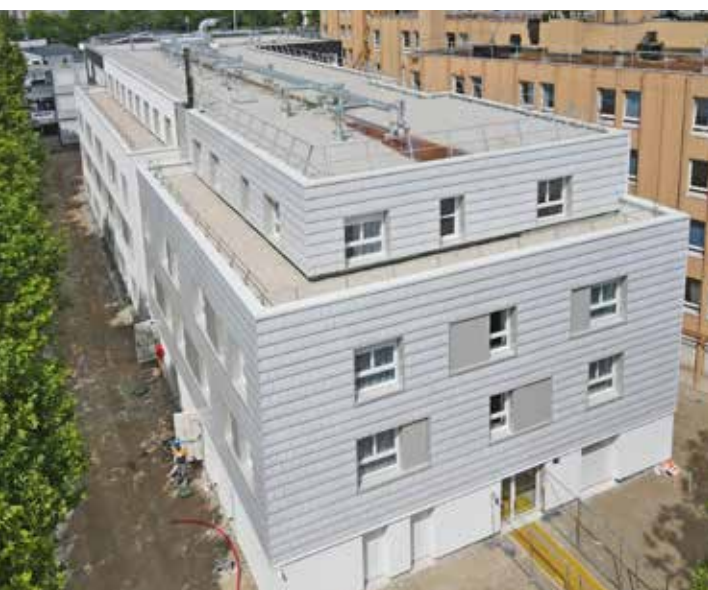
↑ Logements en construction modulaire bois pour Adoma, à Sartrouville (78) ITAR Architecture
