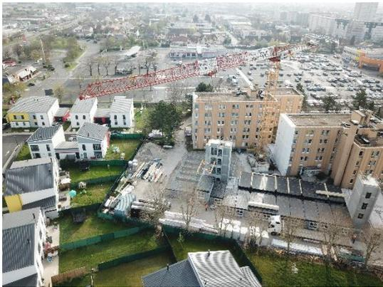
Les premiers mois de l'année 2021 ont été consacrés à la réalisation des éléments de fondation en béton par GCC en vue d'accueillir les 118 modules en bois construits hors-site par Ossaboïs pour le premier bâtiment. Ces modules intègrent l'isolation et les films d'étanchéité à l'air et à l'eau pour une parfaite performance énergétique du bâtiment et comprennent tous les corps d'état techniques (électricité, plomberie, sanitaires, cuisine) ainsi que les finitions (sol, peinture, habillages).
